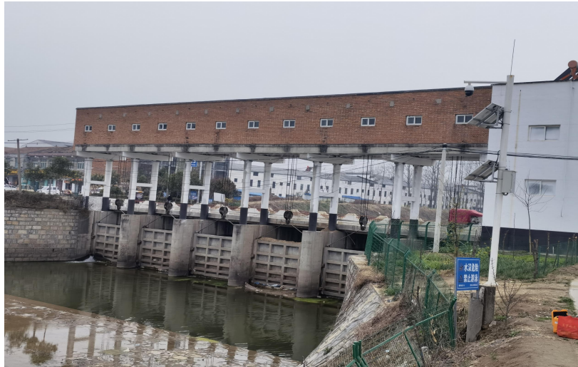
图 8 水闸现场勘察
